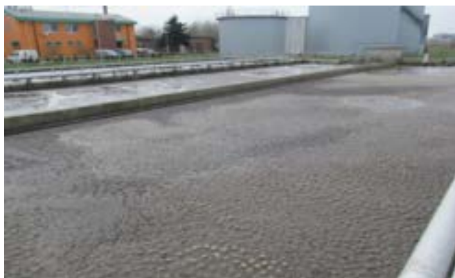
Слика 29. Аеробна разградња на пречистачу у Суботици (Сликао: Б.Цекуш, 2014)
